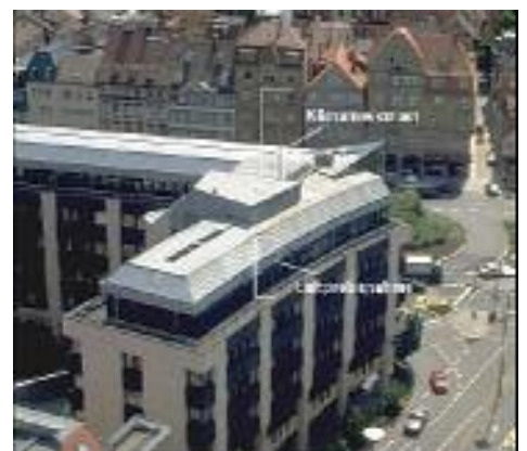
Messstation Stuttgart - Schwabenzentrum
