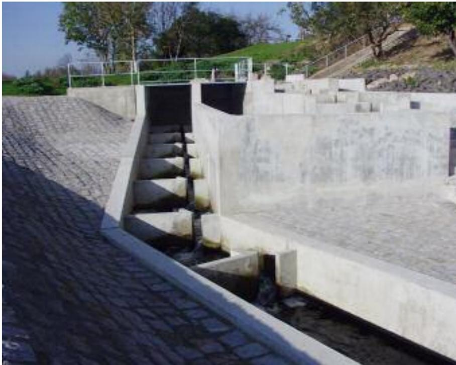
Moderner Vertical-Slot-Pass am Neckarwehr in Ladenburg zwischen Heidelberg und Mannheim. Aufgrund der räumlich beengten Verhältnisse an den bestehenden Schleusen und Kraftwerken werden in Zukunft überwiegend derartige technische Bauwerke die Durchgängigkeit gewährleisten müssen.
